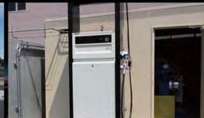
● バイオガスプラント
