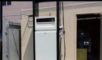
● バイオガスプラント
